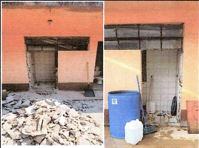
Mejoramiento y ampliación de servicios sanitarios Corte de pared para instalación de baño
