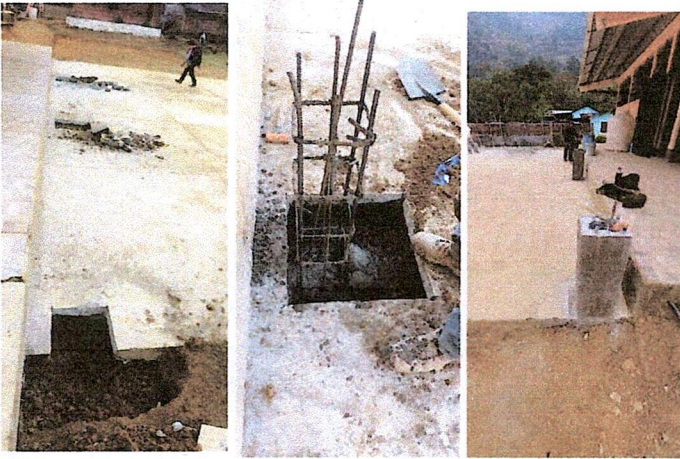
Foto 1: Mejoramiento de estructura tipo pórtico e instalación de lámina troquelada calibre 26, en patio 1 Inicio de bases para estructura
