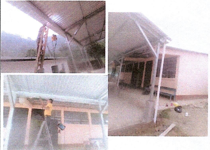
Instalación de canales y bajadas de agua
